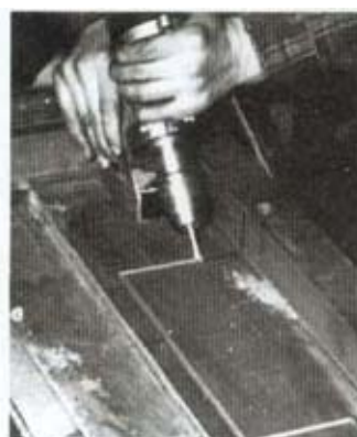
szükséges olajvezetékek elkészítése
