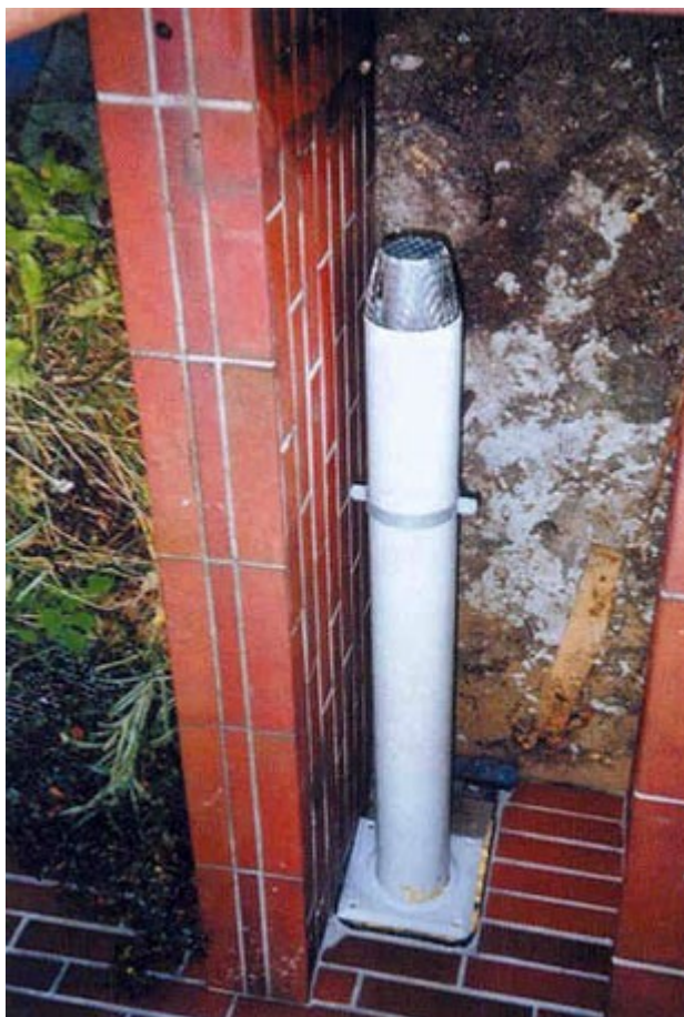
Túlnyomásos égéstermék-elvezető a terasz alatti pincéből. Látványkompenzálás két takarófallal
