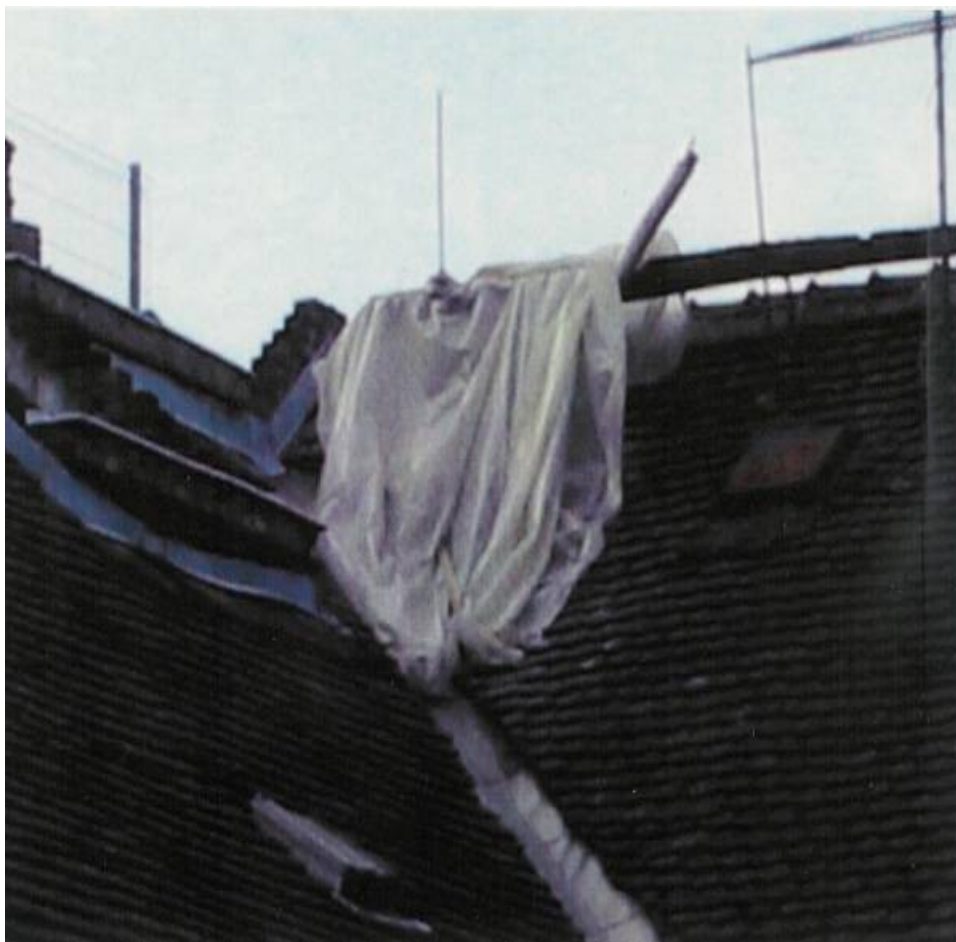
A bontás helyét és környezetét fóliával lefedték (beázást elkerülendő) Ezáltal megakadályozták az égéstermék szabad kiáramlását.
