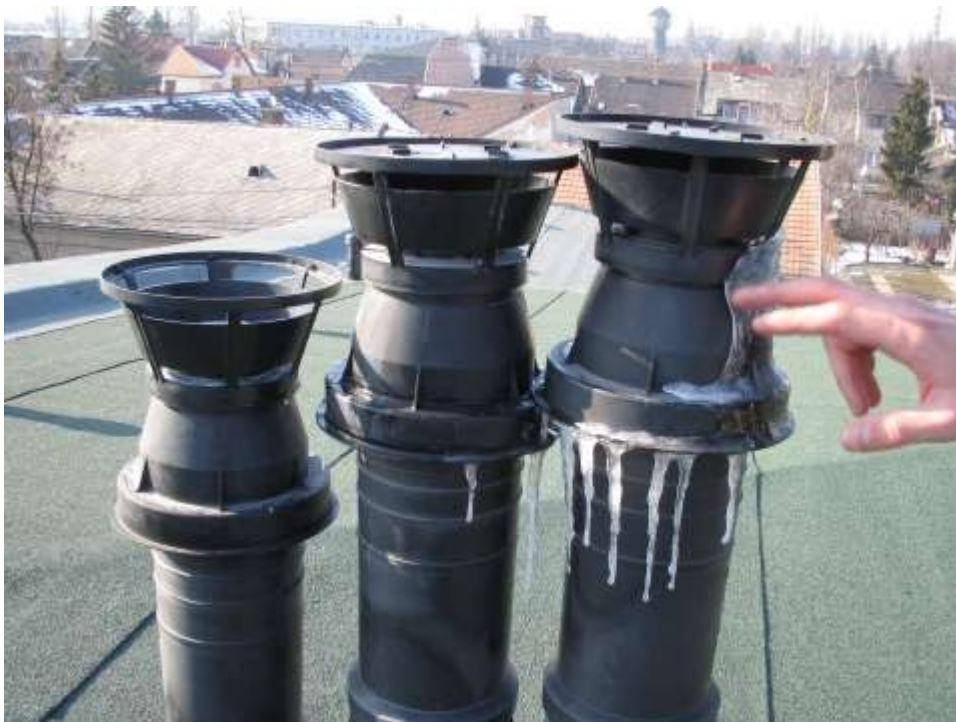
Ha tél, akkor jégcsapok... ("cső a csőben" rendszer)
