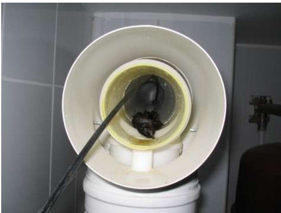
A madárka jobb sorsa "szenderült" (cső a csőben rendszer tisztító- ellenőrző nyílása)
