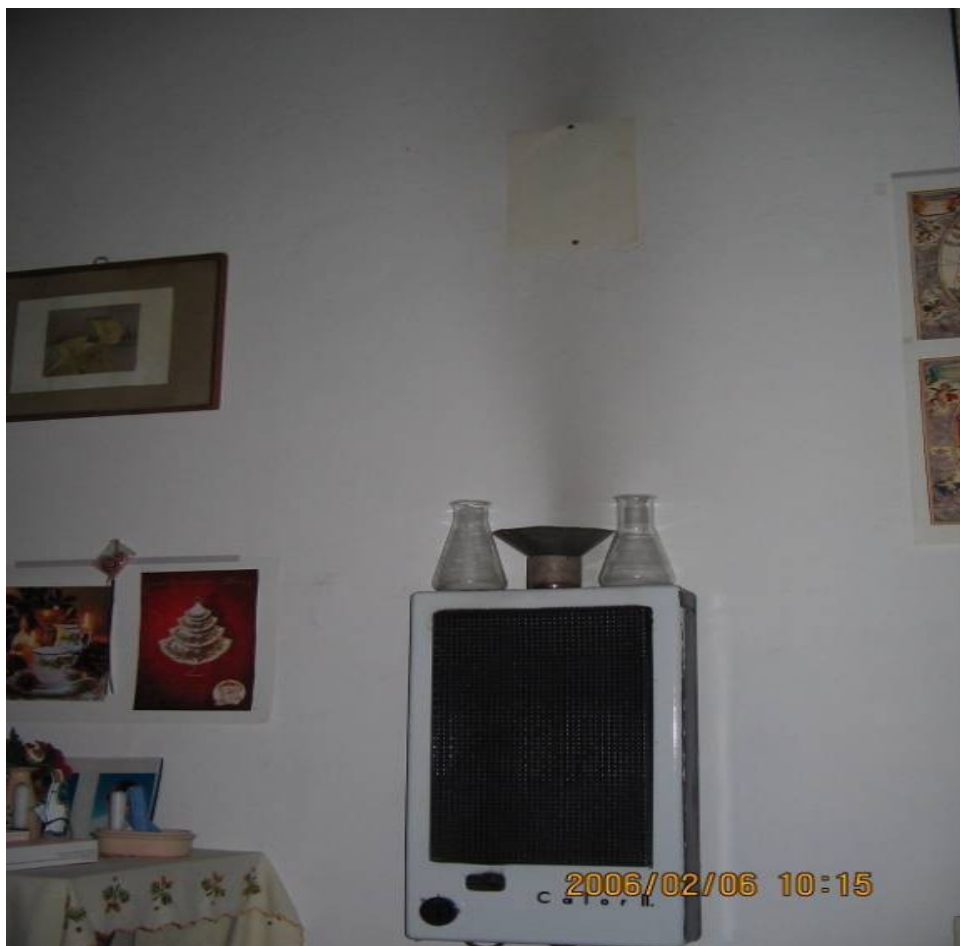
CO (szén-monoxid) mérgezés Szobában elhelyezett, „feketén” szerelt fali fűtő gázkészülék. A füstcsövet valaki eltávolította, a füstcsonkot egy tölcsérrel lefedte, a falihüvelyt (bekötő-nyílást) egy takarólemezzel lefedte
