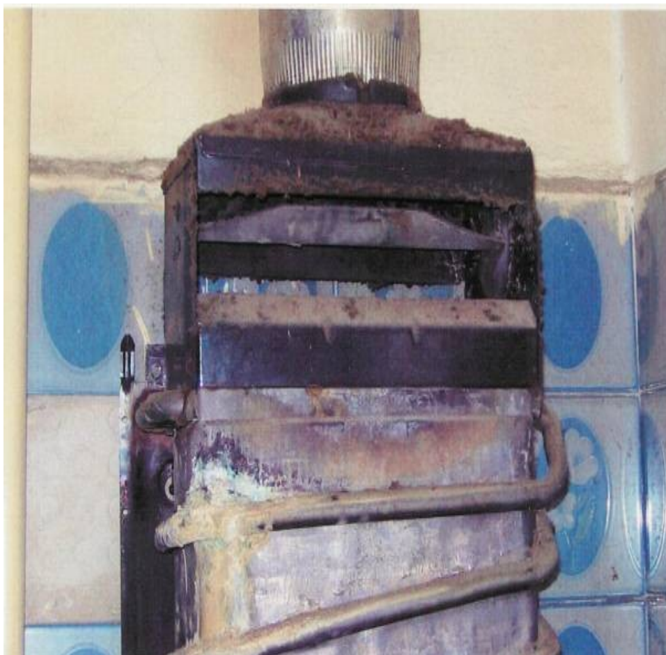
A bontás helyét és környezetét fóliával lefedték (beázást elkerülendő) Ezáltal megakadályozták az égéstermék szabad kiáramlását.
