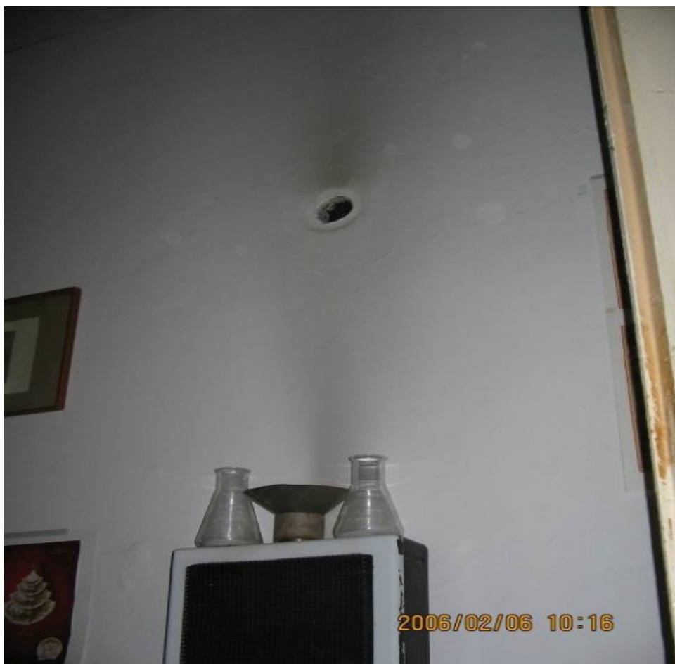
CO (szén-monoxid) mérgezés Szobában elhelyezett, „feketén” szerelt fali fűtő gázkészülék. A füstcsövet valaki eltávolította, a füstcsonkot egy tölcsérrel lefedte, a falihüvelyt (bekötő-nyílást) egy takarólemezzel lefedte
