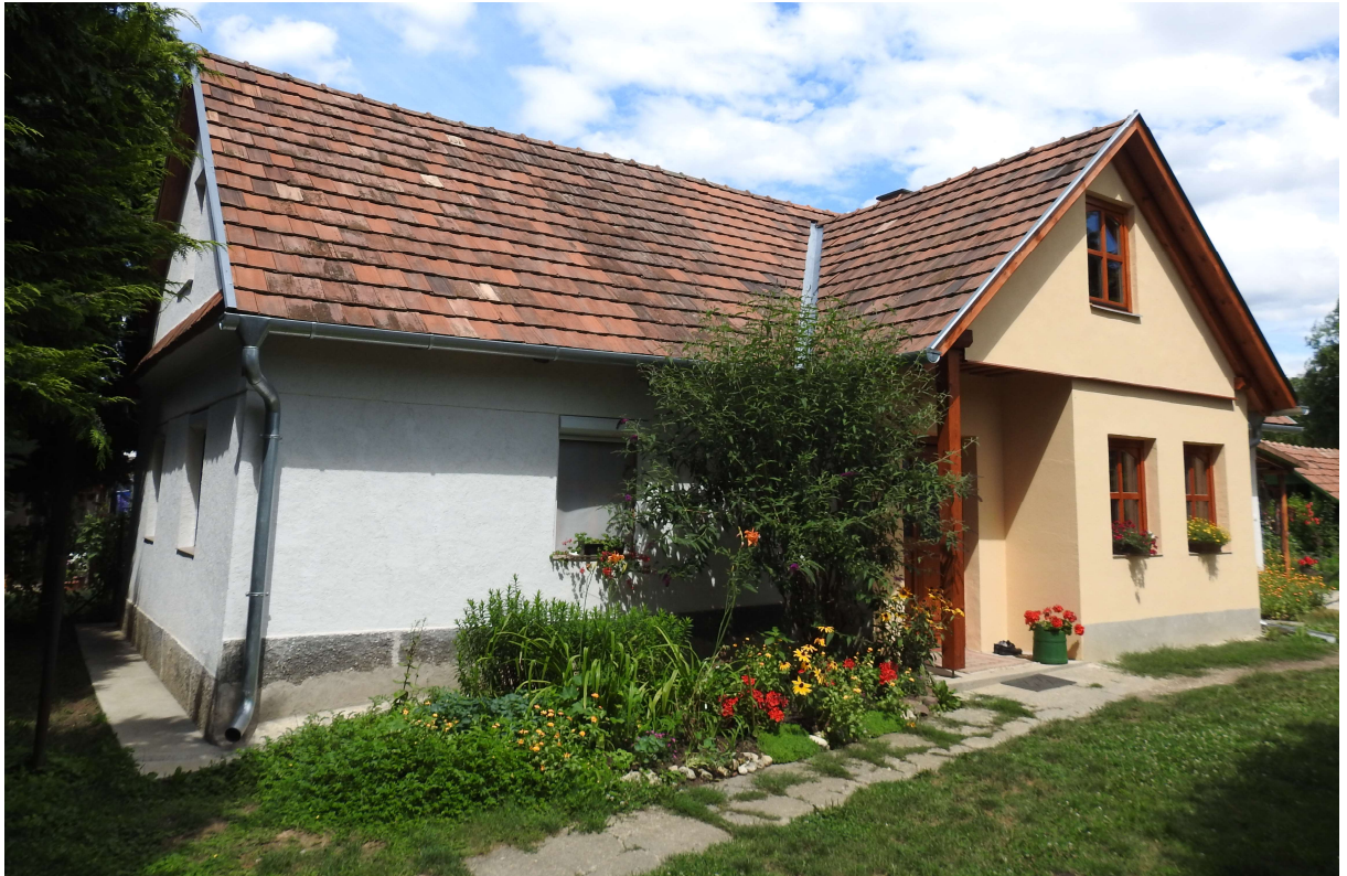
Kedvező arányú és nyílászáró elrendezésű véghomlokzat és udvari bejárat
