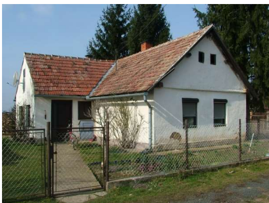
Petőfi S. u. 43. – Lakóház
