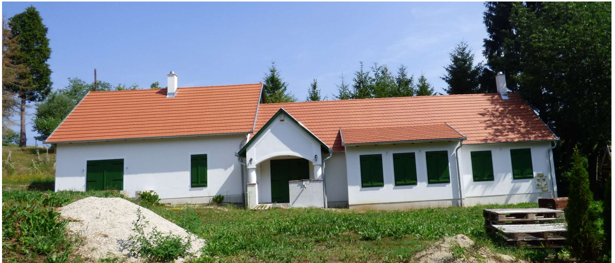
Az őrségi hagyományos kódisállásos házak formavilágát mai építési technológiára és esztétikai igényekre átfogalmazott lakóépület homlokzata
