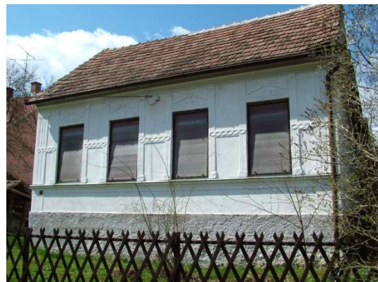
Dózsa Gy. u. 42. – Lakóház
