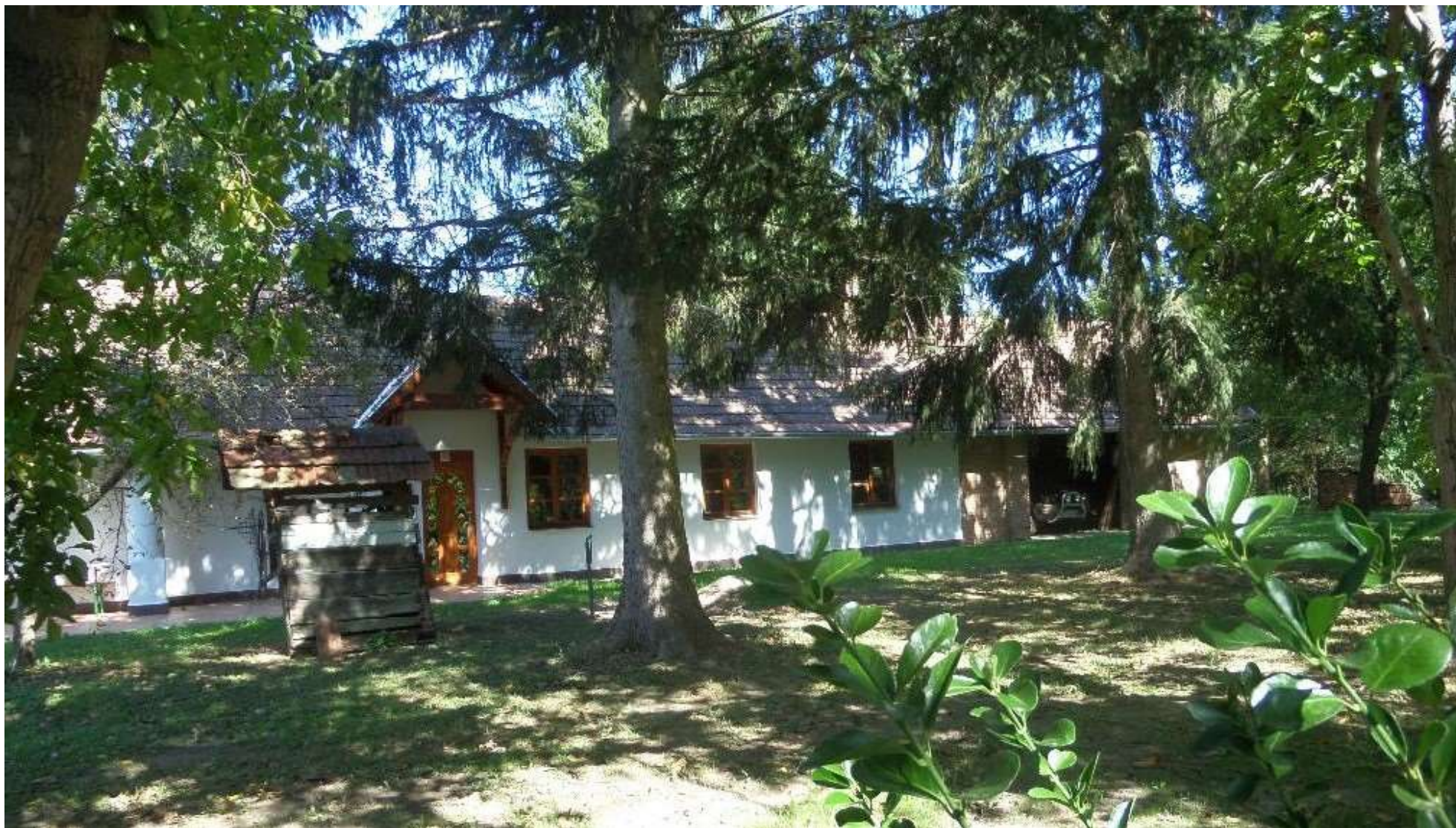
Az előbbi ház bejárata, udvari homlokzata, valamint a hozzáépült pajta
